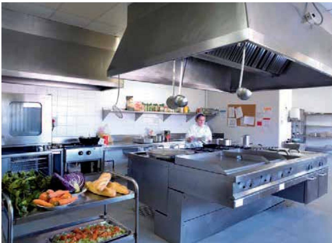
Cocina de Collado Villalba (Madrid).
